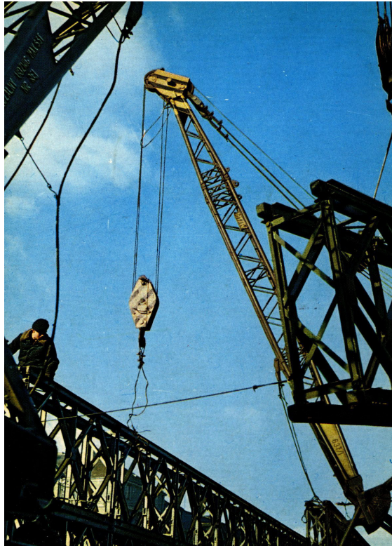
Fot. 5. Ludowe Wojsko Polskie. Budowa mostu (fot. S. Syndoman; źródło: kolekcja autorów). [Ramie dźwigu na tle nieba. Młody człowiek w mundurze po lewej stronie.]
