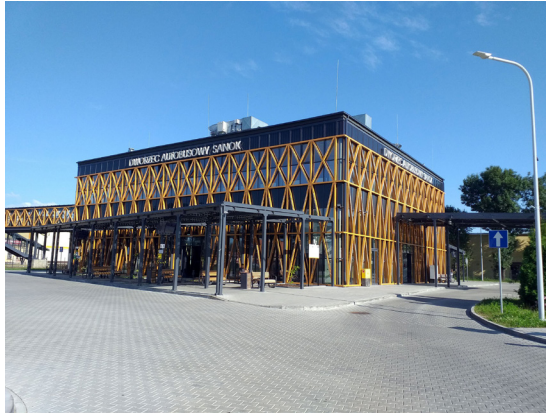
Fot. 6. Dworzec Multimodalny w Sanoku (11 września 2019 r.)
