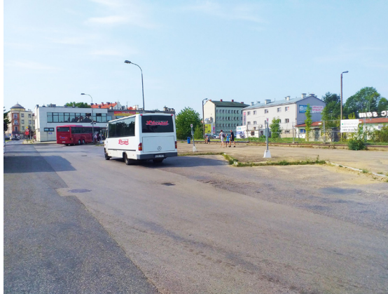
Fot. 1. Dworzec autobusowy w Gorlicach (29 sierpnia 2019 r.) Wszystkie fotografie wykonał autor książki
