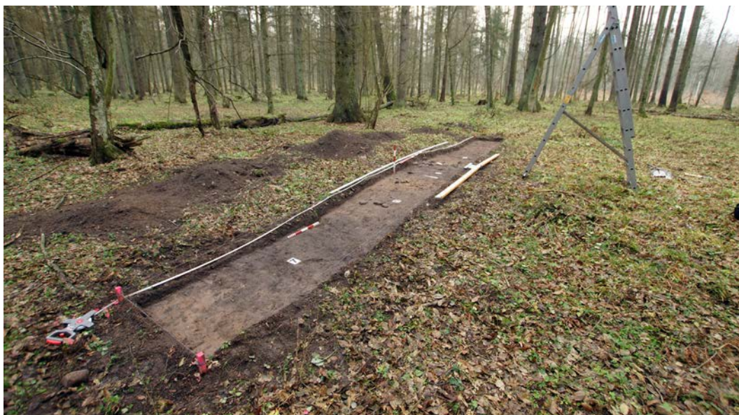
Ryc. VII.47. Leśnictwo Przechody, stan. 8. Widok ogólny wykopu od południowego zachodu (stan po usunięciu ściółki i humusu współczesnego). Fot. D. Krasnodębski
