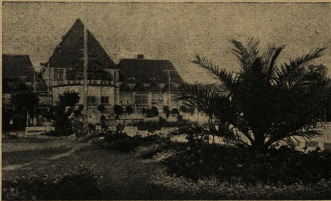
Gdańsk. Sopoty. Ogród Domu Uzdrawiskowego
