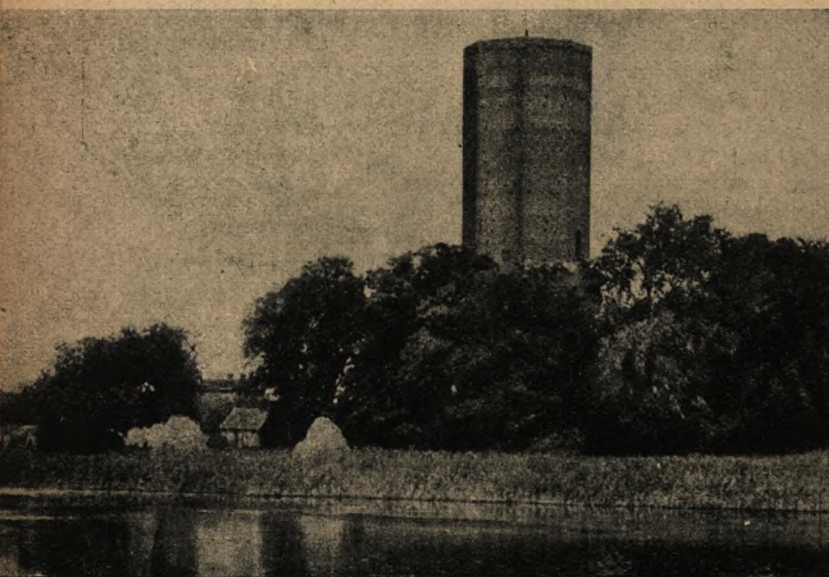
Wielkopolska. Kruszwica. Mysia wieża nad Gopłem.
