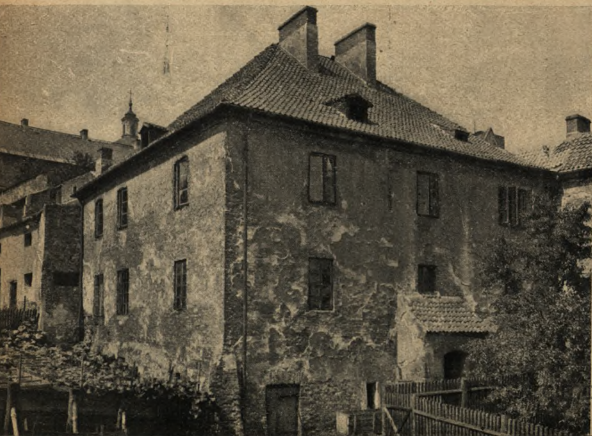
Stary dom na tyłach klasztoru P.P. Sakramentek.
