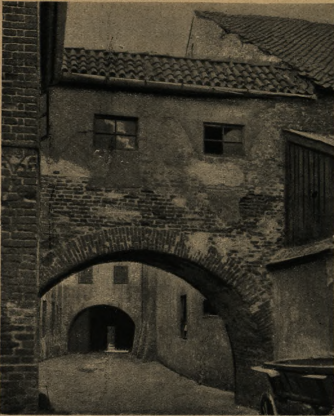
Kryty chodnik broni. Fragment dawnych murów obronnych przy ulicy Podwale.
