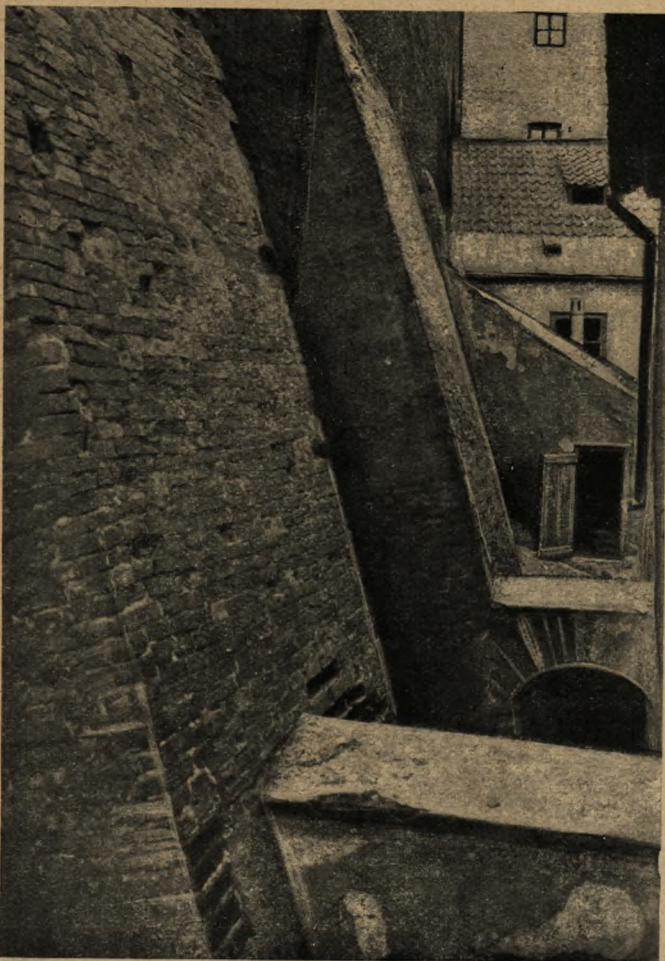
Skarpy murów obronnych przy ulicy Mostowej.
