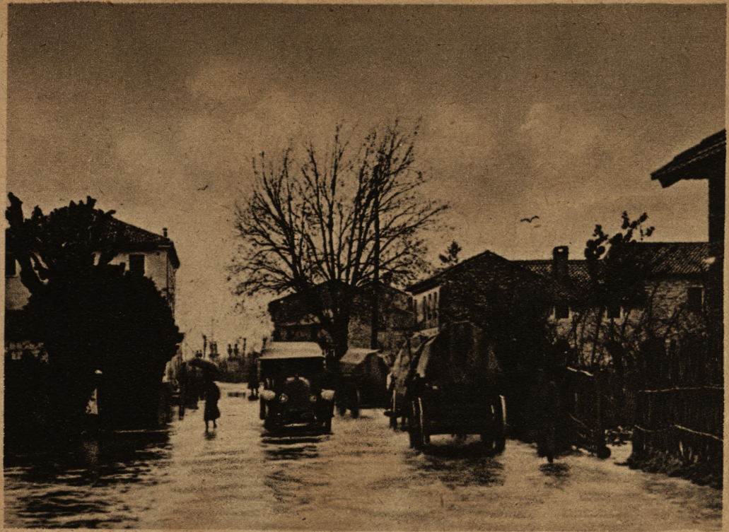
Jak się zaczęła klęską mocarstw centralnych: Dnia 17 czerwca 1918, gdy Austriacy podjęli nad Piawą ofensywę, koalicja spuściła śluzę i zatopiła cały teren, przez co ofensywa została złamana. Fotografia przedstawia widok wsi zalanej nad Piawą.
