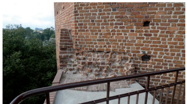
Ryc. 28a, b. Zamek w Kruszwicy, relikty blankowania muru obwodowego, stan sprzed i po konserwacji. Fot. M. Małachowicz
