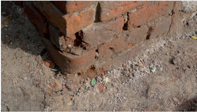
Ryc. 38. Zamek w Kruszwicy, zaokrąglona kształtka średniowiecznego węgara przejścia korytarza w piwnicy. Fot. M. Małachowicz
