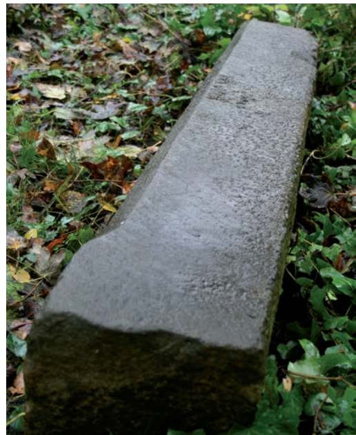
Ryc. 41. Zamek w Kruszwicy, kamienny słupek portalu wewnętrznego. Fot. M. Maciejewski
