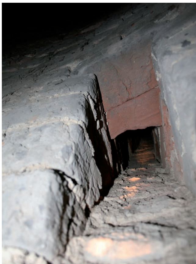
Ryc. 24. Zamek w Kruszwicy, negatywy po ukośnych belkach (wsporników) w ścianie obwodowej lochu głodowego. Fot. M. Małachowicz
