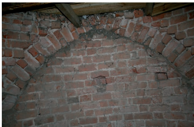
Ryc. 25. Zamek w Kruszwicy, relikty ceglaneanego sklepienia nad lochem głodowym. Fot. M. Małachowicz
