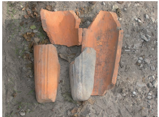
Ryc. 4. Zamek w Kruszwicy, średniowieczne dachówki typu mnich – mniszka. Fot. M. Małachowicz
