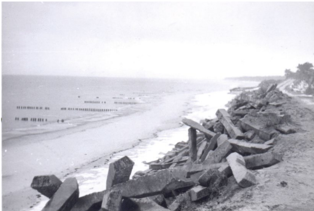
Fot. 2. Awaryjne zabezpieczenie brzegu w rejonie Kuźnicy (wał z gliny z narzutem z żelbetowych podkładów kolejowych, gruzu betonowego i kamieni) wykonane po katastrofalnym sztormie z 1983 r. (październik 1989 r.) (autor nieznany) Emergency coastal protection near Kuźnica (a clay embankment with RC railway sleepers, concrete debris and stones) installed following the catastrophic 1983 storm (as pictured in October 1989) Źródło: Archiwum Zakładu Hydrotechniki Morskiej, Instytut Morski.
