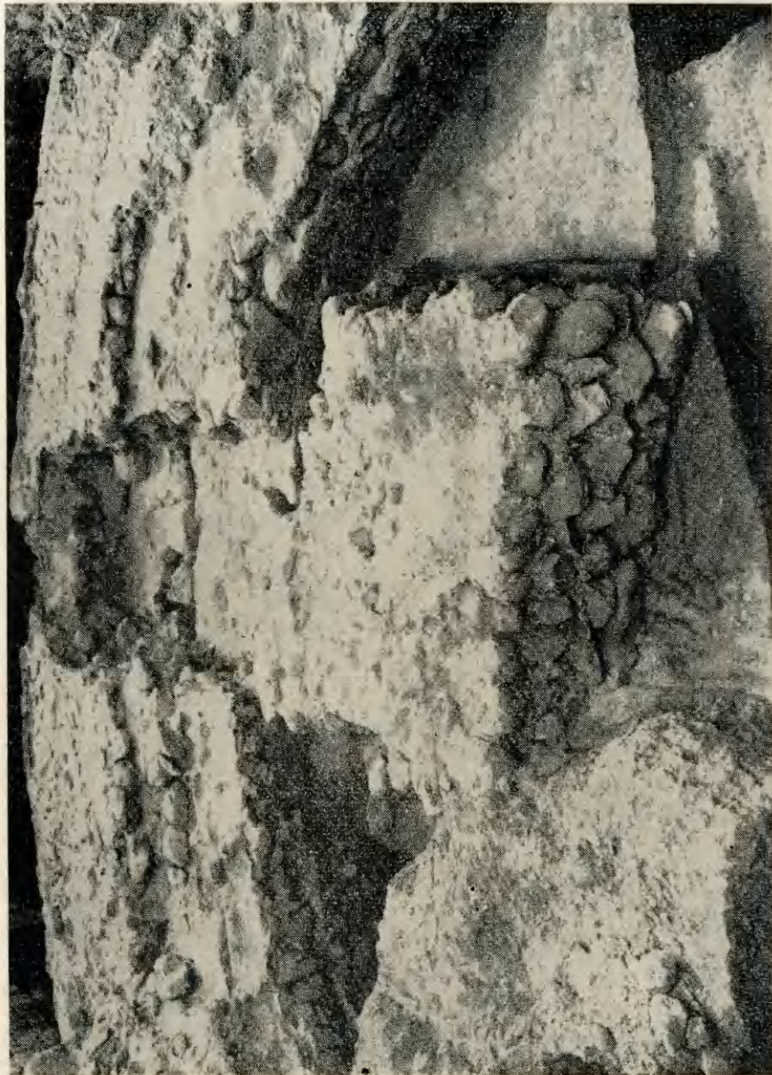
Ryc. 3. Gniezno. Katedra. Na pierwszym planie fundament ołtarza, a w głębi fundamenty dwóch absyd Fot. Z. Różański
