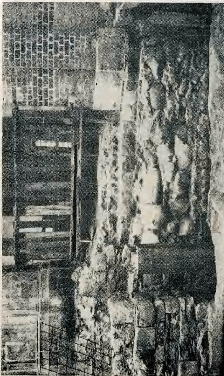
Ryc. 5. Gniezno. Katedra. Fundament i częściowo zachowane lico południowej ściany romańskiego prezbiterium Fot. Z. Różański
