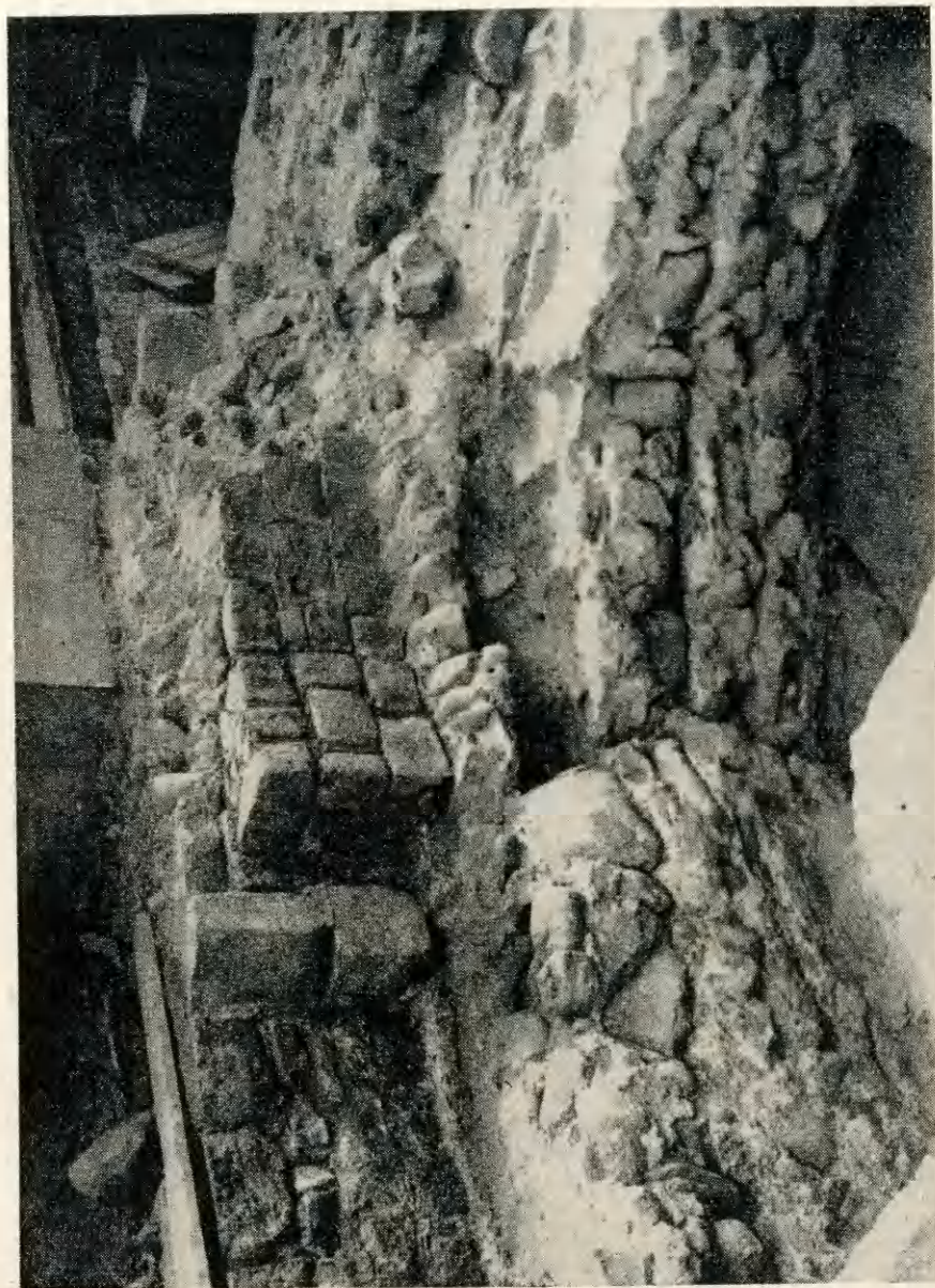
Ryc. 6. Gniezno. Katedra. U dołu fundament starszej absydy, a u góry częściowo zachowane lico ścian młodszej absydy
