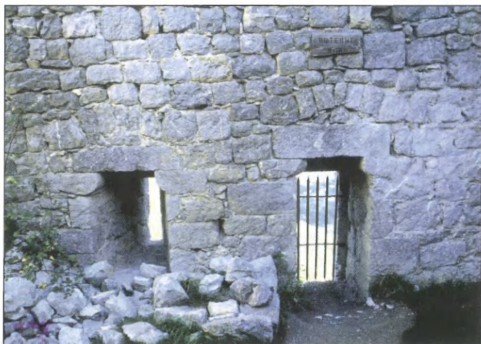
Fig. 6. Archère à fente simple avec linteau sur corbeaux au profil en quart de rond et arc de décharge (archère flanquant la poterne nord de Puilaurens).
