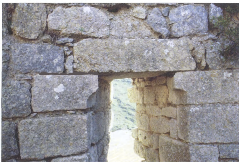
Fig. 7. Linteau sur corbeaux au profil à cavet droit (archère à bêche: tour est de la première enceinte d'Aguilar).
