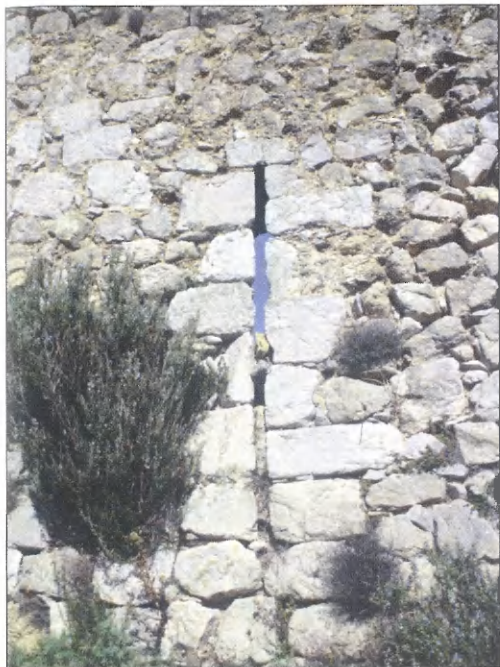
Fig. 1. Archère à fente simple (Aguilar: face sud du logis).
