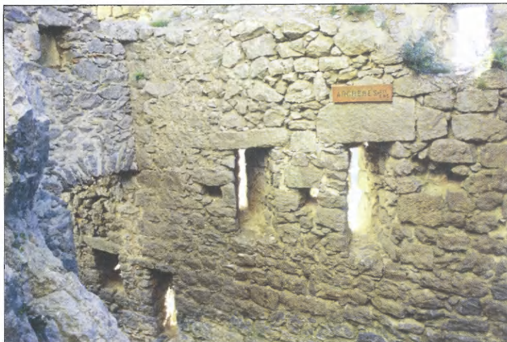
Fig. 2. Petites archères archaïques ou meurtrières plus récentes (?): flanquement de l'entrée et de l'escalier extérieur dans la courtine sud de la seconde enceinte de Puilaurens.
