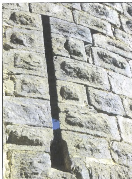
Fig. 4. Archère à bêche: dans tour sud-est (à bossages) flanquant la poterne est de Puilaurens.
