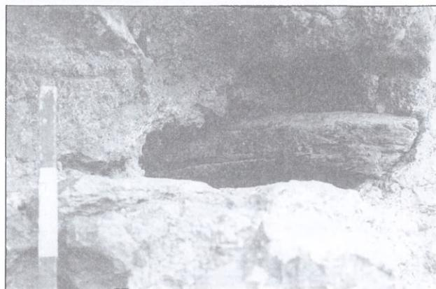
Fig. 9. Pièce de bois introduite dans une maçonnerie de terre pour en renforcer la résistance.
