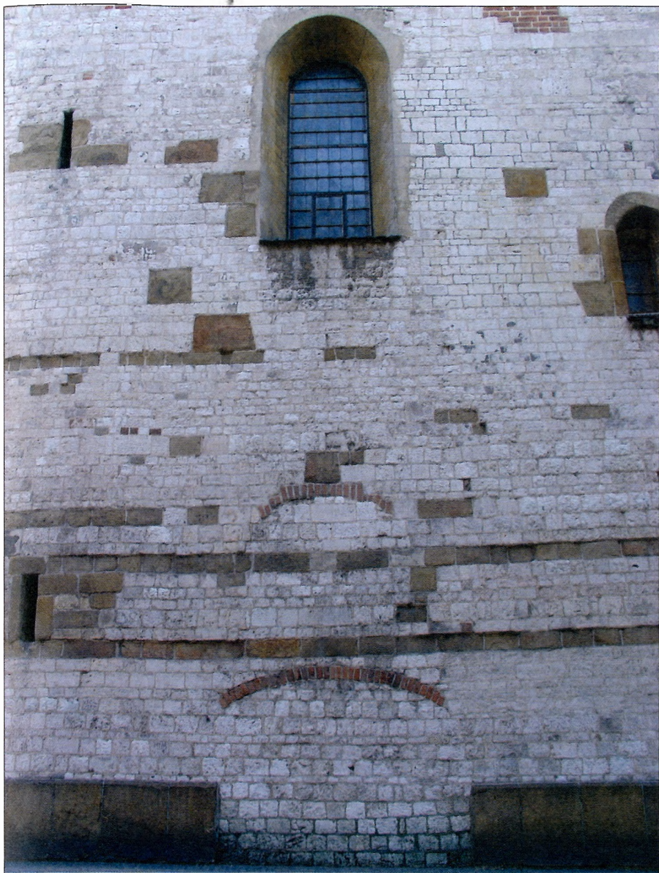
Ryc. 3. Klasztor klarysek w Krakowie. Zachodnia fasada kościoła przy ul. Grodzkiej z widocznym zarysem sklepienia po kaplicy grobowej zwanej Kalwarią, zlikwidowanej w 1844 r. W średnio-wieczu i nowożytności miejsce to było otoczone wysokim murem (fot. O.M. Przybyłowicz)
