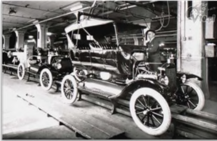
Rys. 5.2. Tak wyglądała klasyczna taśma produkcyjna w zakładach Forda około roku 1915
