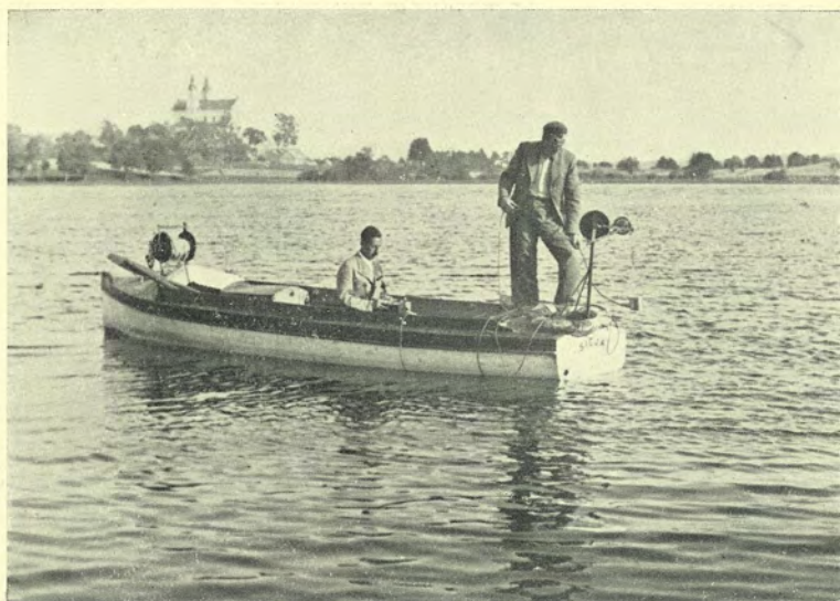
Pomiary aktynometryczne przenikania promieni słonecznych w głąb wody.
