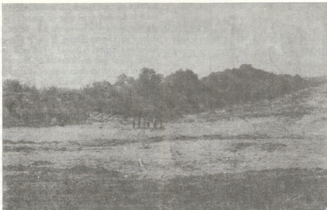
Fig. 3. Cedynia. L'étude de l'ensemble des foyers (28 VI 1972) situés près du débouché d'un ravin profond, découverts par les bulldozers.
