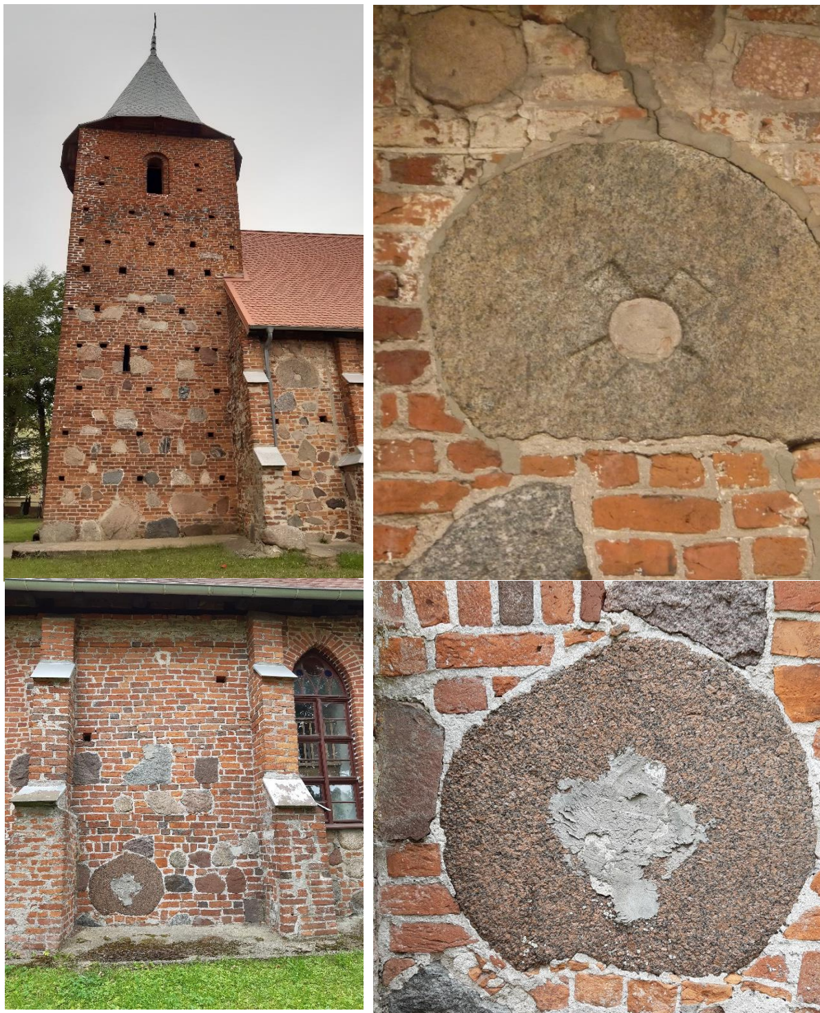
Ryc. 4. Umieszczenie kamieni młyńskich w murach nawy kościoła w Dąbrowie (fot. D. Brykała)
