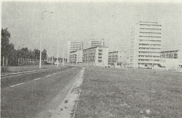
Ryc. 9. Widok dwukierunkowej arterii komunikacyjnej w Bydgoszczy rozdzielonej pasem trawnika, na którym rzuca się w oczy całkowity brak roślin drzewiastych. Fot. H. Chylarecki
