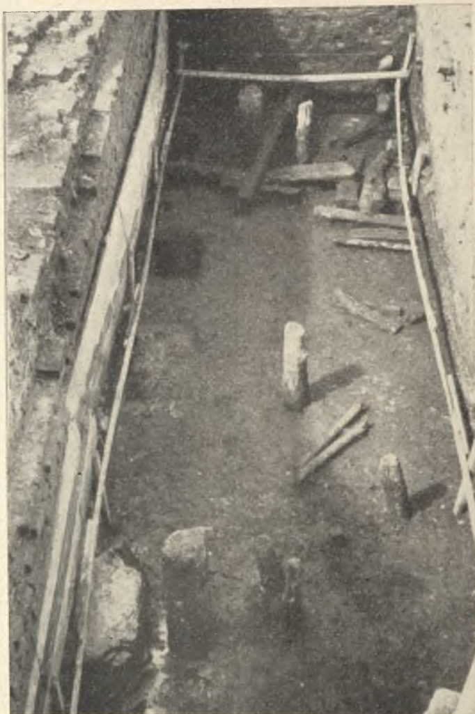
Ryc. 7. Gdańsk, stan. 4, wykop V — „civitas”. Dębowe pale portowe z XII wieku. Po lewej dwa pale cumownicze o średnicy 30 cm. Na prawo dwie linie pali pomocu portowego o średnicach od 16—18 cm. Widok od strony wschodniej
