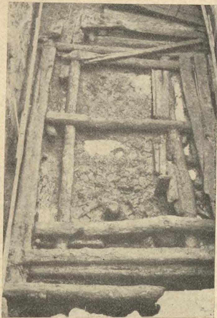
Ryc. 6. Gdańsk, stan. 4, wykop V — „civitas”. Dom zrębowy wraz z fragmentami podłogi i chodnikiem wyłożonym dranicami z pocz. XIII w. (5 poz. os.). Pomiędzy legarami podłogi wierzchołki pali portowych z XII wieku. Widok od strony zachodniej
