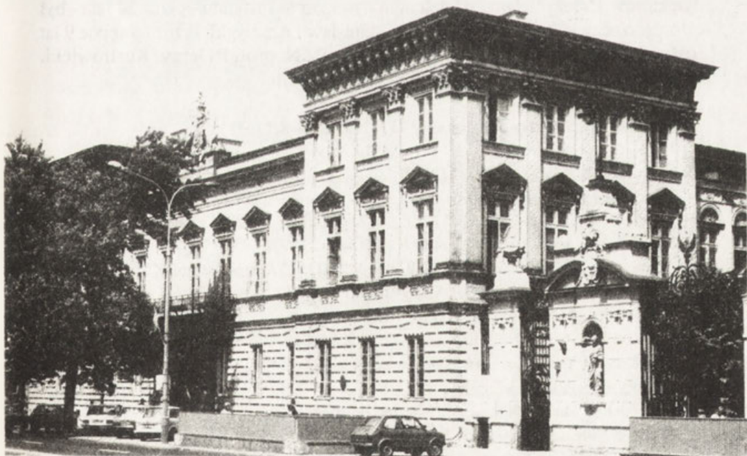
Fot. 1. Pałac Uruskich na Krakowskim Przedmieściu 30 w Warszawie. Siedziba Instytutu The Uruski Palace at Krakowskie Przedmieście 30 in Warsaw. This is where the main part of the Institute is located
