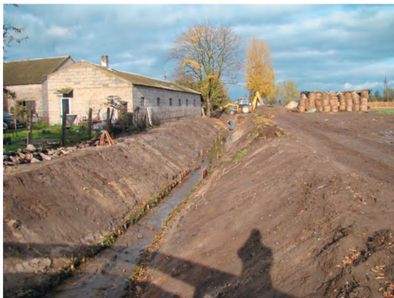
Fot. 5. Odnowiony kanał odprowadzający wodę z odkrywki "Tomisławice" we wsi Boguszyce (październik 2008 r.) (Fot. D. Brykała) Photo 5. New canal in Boguszyce village transported water from the area of opencast brown-coal mine "Tomisławice" (October 2008) (Photo D. Brykała)
