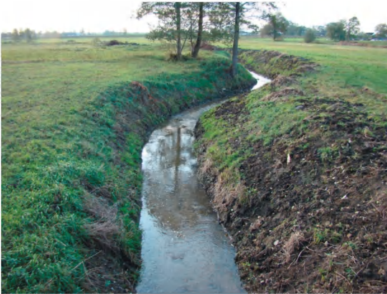
Fot. 8. Pogłębione koryto rzeki Pichna przygotowane do odprowadzania wody z odkrywki „Tomisławie” (październik 2008 r.) (Fot. D. Brykała) Photo 8. Deeped and regulated channel of the Pichna river (October 2008) (Photo D. Brykała)
