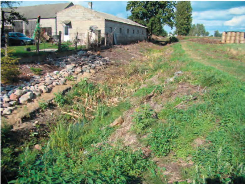
Fot. 4. Zarośnięty rów melioracyjny we wsi Boguszyce (sierpień 2008 r.) (Fot. D. Brykała)
