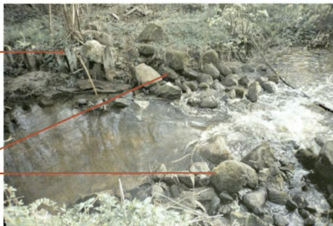
Fot. 6. Dawne piętrzenie stawu młyna Źelazne. Piętrzenie zniszczone w latach 50-tych XX w. Photo 6. The old mill damming of the pond at Źelazne destroyed in the 1950's.
