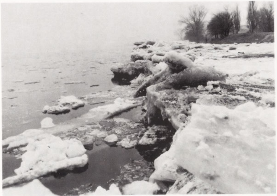
Fot. 29. Ściana ścienia poniżej stopnia wodnego Włocławek (km 702,5) powstała w okresie zejścia zatoru (15 marzec 1985). Wysokość ściany ścienia od 1,5 do 2,0 m.
