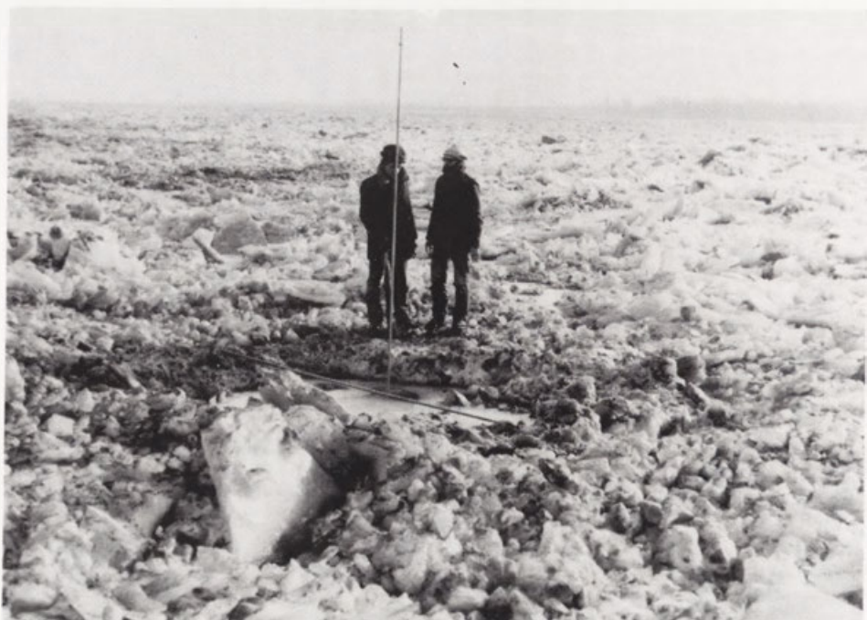
Fot. 44. Miejsce eksplozji ładunku wybuchowego (40 kg) wyłożonego na powierzchni zatoru (km 650, luty 1982). Fotografia wykonana około 15 minut po eksplozji.
