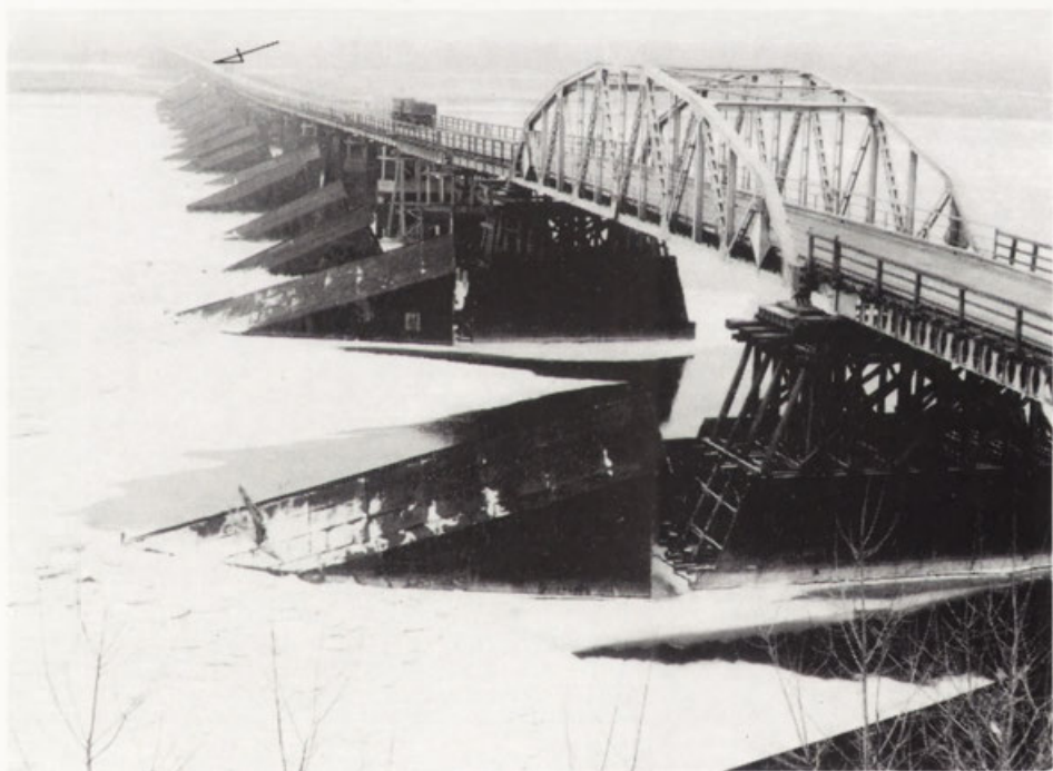
Fot. 51. Drewniany most drogowy w Wysogrodzie (21 luty 1984). Most pełni rolę przegrody lodowej. Poniżej mostu widoczna rozległa plień.
