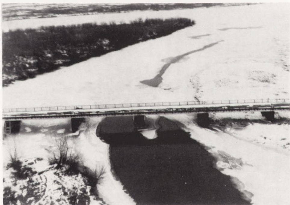
Fot. 20. Boczná odnoga („kanał ulgi”) w profilu mostu drogowego Wyszogród (zdjęcie lotnicze, km 587,8, luty 1987). Płoń poniżej mostu związana z „efektem upustu dennego”. Powyżej mostu charakterystyczne wypłuczysko.
