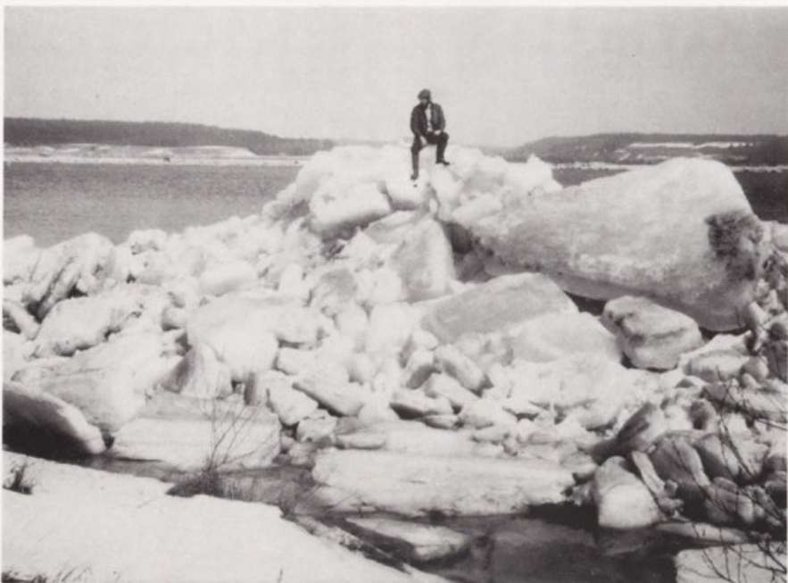
Fot. 11. Spiętrzenie kry (grubość około 50 cm) i pulpy śryżowej na zaporzce bocznej w Popłacinie (km 635, 1 kwiecień 1979). Maksymalna wysokość spiętrzeń około 6 m. Wysokość spiętrzeń ponad koronę zapory około 3 m.
