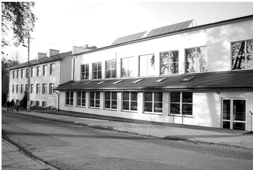
Fot. 5. Sala gimnastyczna przy Publicznym Gimnazjum w Osjakowie Gym at Public Lower-Secondary School in Osjakowo
