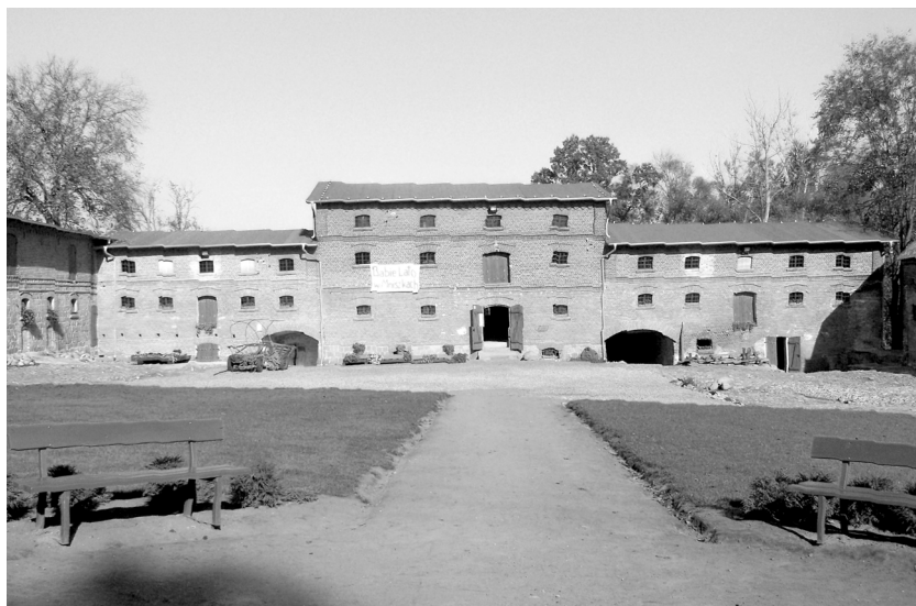
Fot. 1. Wyremontowane budynki Centrum Edukacji Regionalnej i Przyrodniczej w Mniszkach Renovated buildings of the Centre for Regional and Natural Education (CERiP) in Mniszki
