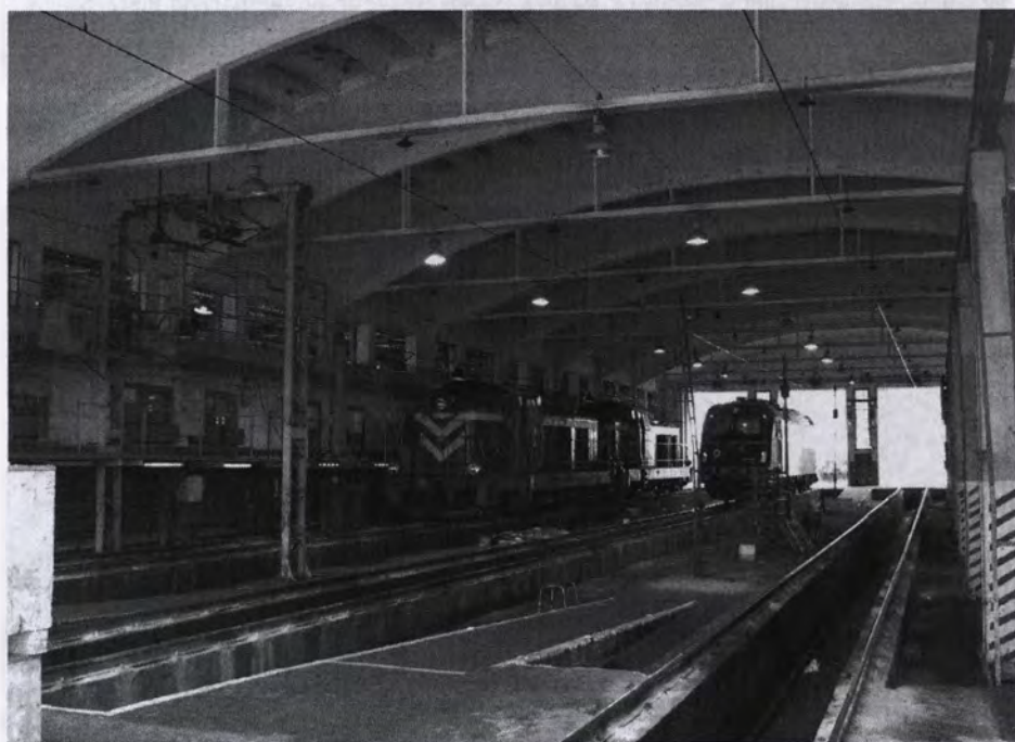
Il. 13. Wnętrze hali lokomotywowni Warszawa-Olszynka Grochowska, fot. Jacek Wardęcki, 2014 r.
