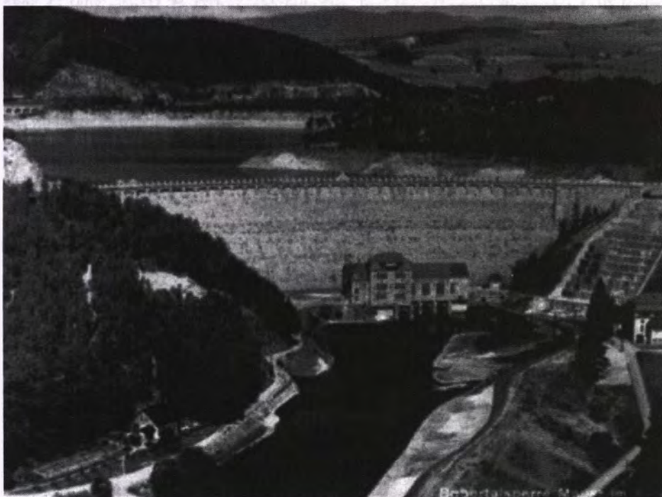
Rys. 8. Elektrownia i zapora w Pilchowicach. Źródło: Jeleniogórska Biblioteka Cyfrowa, sygn. 4449
