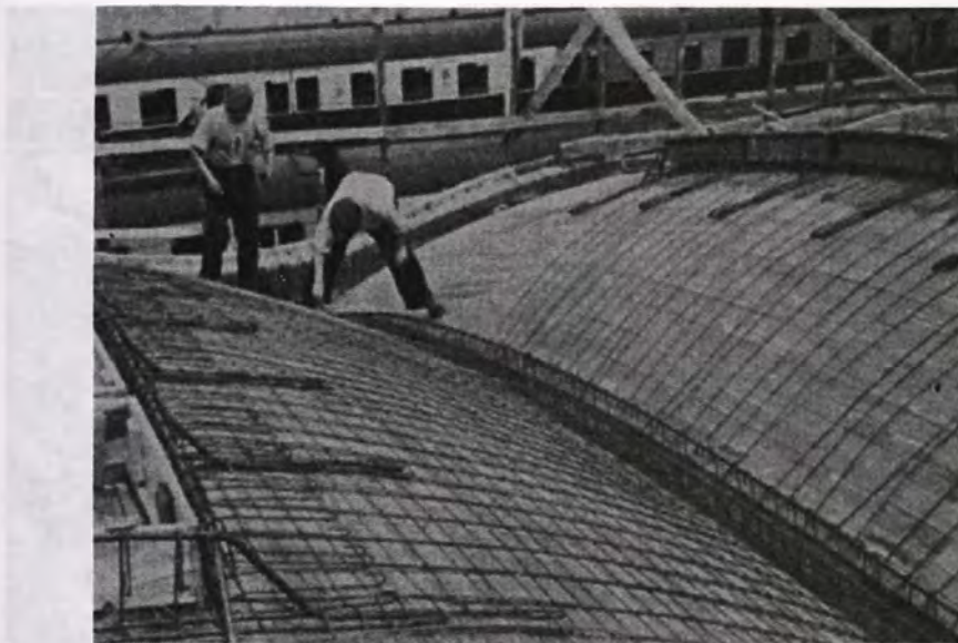
Il. 6. Widok zbrojenia łupiny żebra węzłowego i żeber świetlikowych, W. Żenczykowski: Hala do rewizji...
