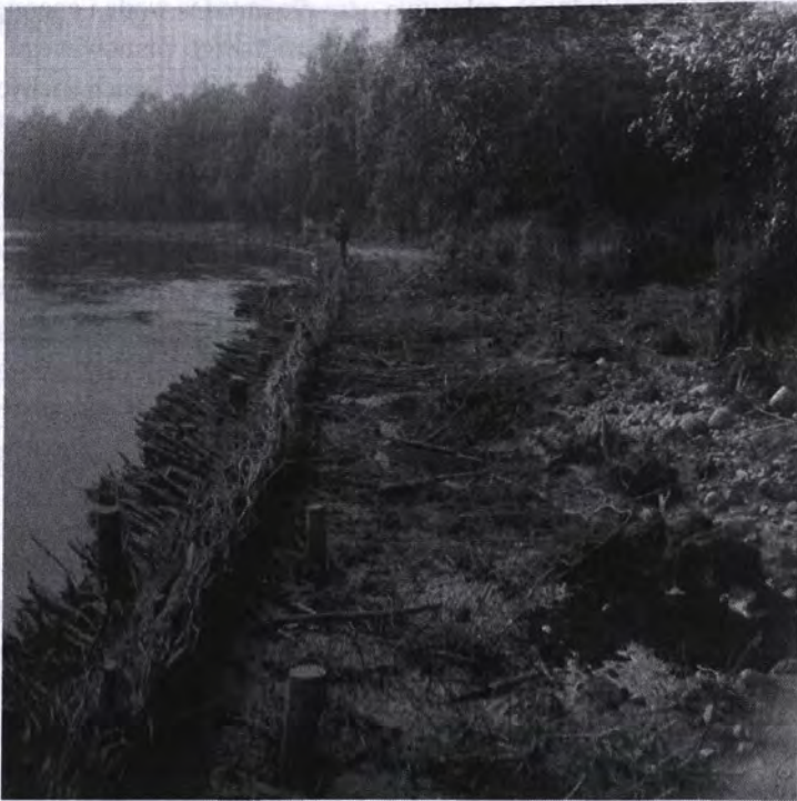
Rys. 4. Umacnianie brzegów rzeki Bóbr w 1911 roku w dolnym biegu. Źródło: AP Wrocław, Wydział Samorządowy Prowincji Śląskiej, sygn. 3249, Photographien betr. Bober (Grenzstrecke) , s. 151
