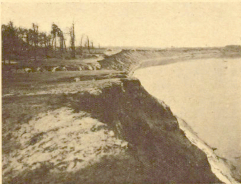
Fig. 2. Stromy brzeg Wisły, widziany od Bielán w stronę Młocin. Na pierwszym planie widoczne są tworzące się wyrwy w piasku i wąwóz, posunięty głęboko w las bielański. Na dalszym planie tworzące się zakole Wisły w piaszczystej części brzegowiska z nacinającymi jego powierzchnię wąwozami. W dali widać las młociński i wieś Młociny.
