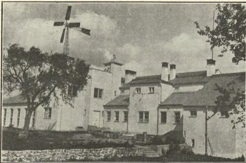
Rys. 2. Stacja Hydrobiologiczna. Budynek główny.
