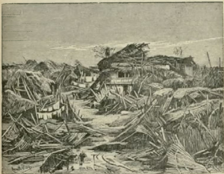
Zniszczenie wskutek Taifunu.
