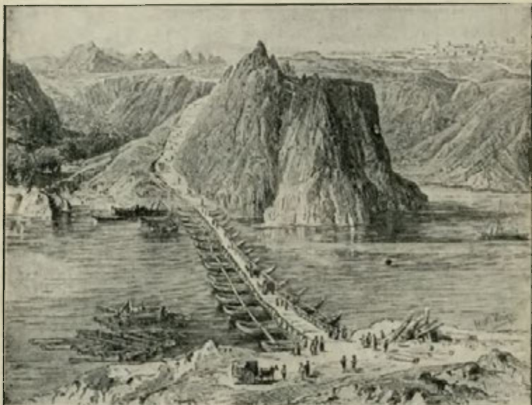
Most łyżwowy na Indzie.
