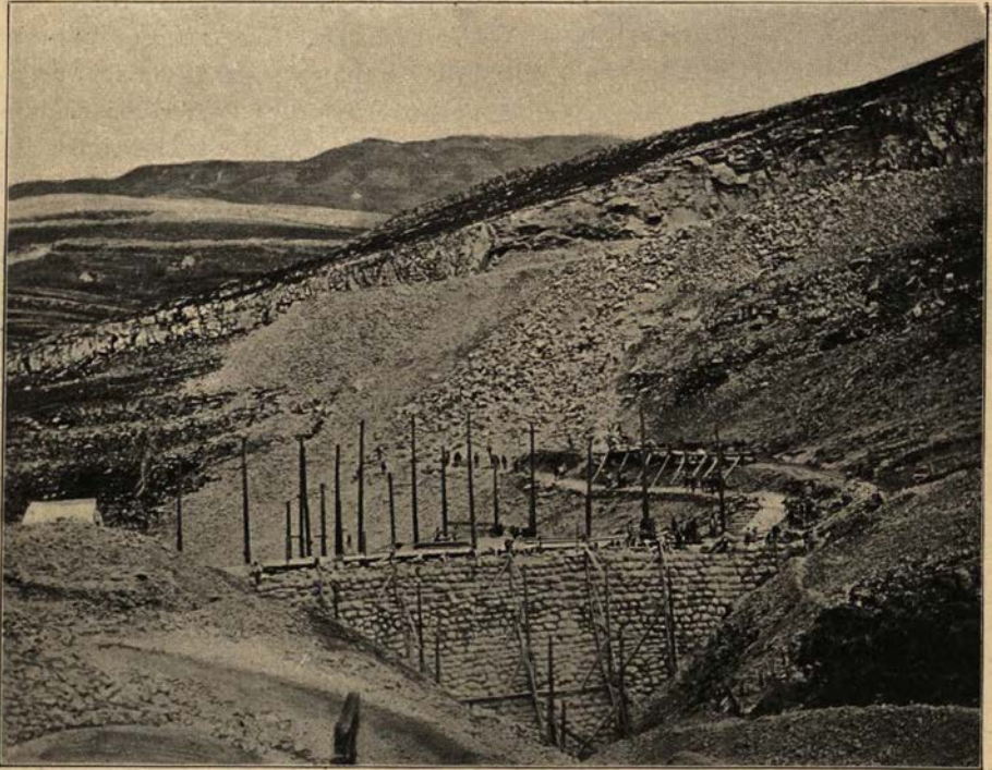
Arbeiten an der Kline bei Gacko.
