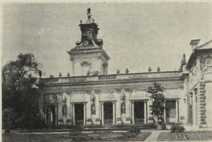
Ryc. 10. Wilanów. Widok galerji pałacowej od strony parku.
