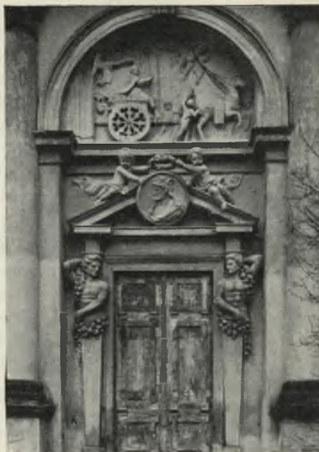
Ryc. 34. Wilanów. Portal galerji pałacowej od strony dziedzińca.
