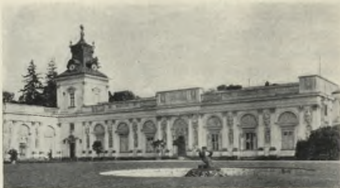
Ryc. 25. Wilanów. Boczne skrzydło pałacu od strony dziedzińca.
