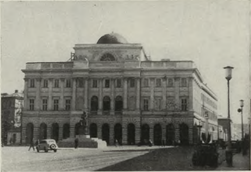
77. Pałac Staszica — siedziba Towarzystwa Naukowego Warszawskiego po ostatniej rekonstrukcji i rozbudowie w 1950 r.
