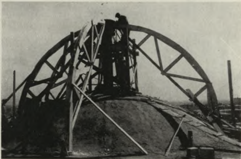
65. Pałac Staszica — wiązanie konstrukcji hełmu kopuły, wykonane wiosną 1949
