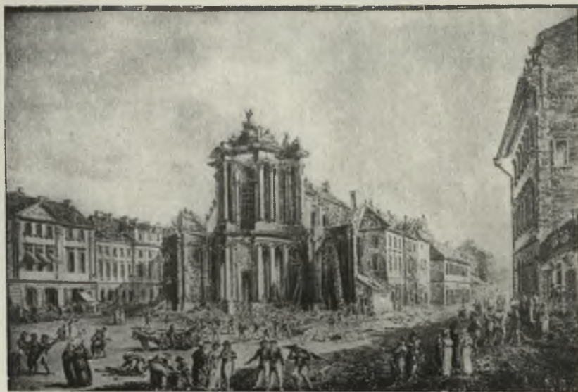
25. Kościół O.O. Dominikanów-Obserwantów na Krakowskim Przedmieściu w czasie rozbiórki.
