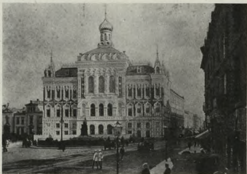
39. Pałac Staszica po przebudowie w 1892--3 w/g proj. arch. M. Pokrowskiego
