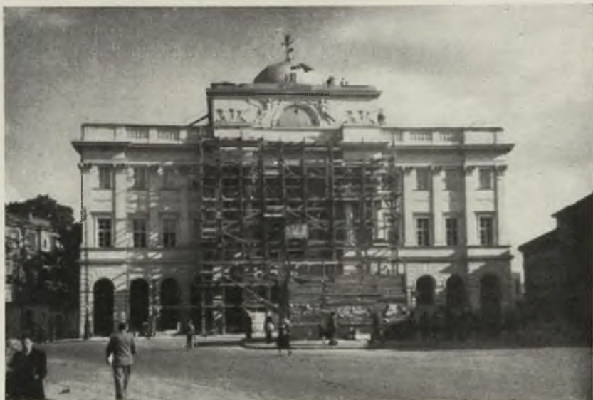
66. Pałac Staszica — ostatnie roboty elewacyjne przy fasadzie głównej i roboty kamieniarskie przy remoncie cokołu pomnika Kopernika w 1949 r.
