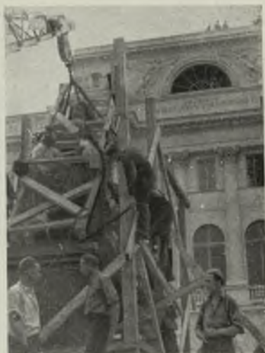
91. Montaż figury Kopernika po przeprowadzeniu robót konser- watorskich w 1949 r.
