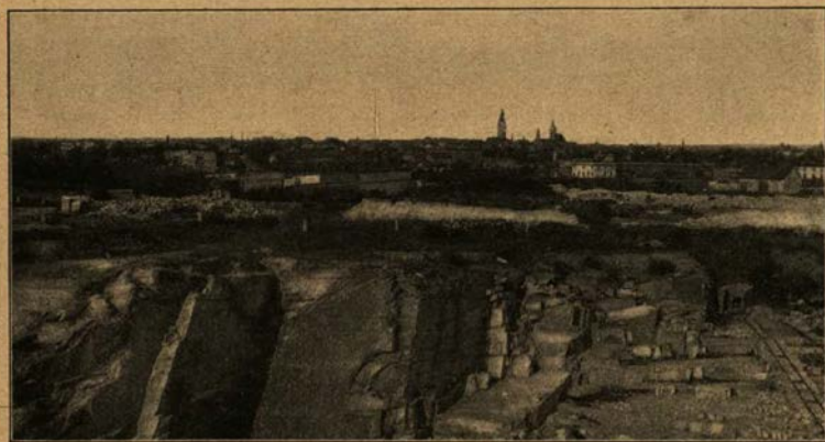
Strehlen, von den Steinbrüchen aus.
