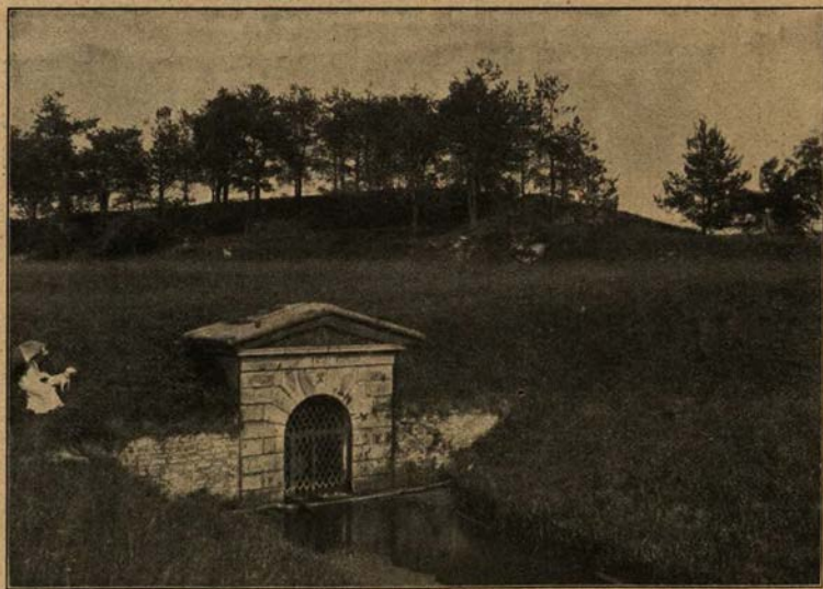
Rundloch des Kgl. Friedrich-Stollen. (Photogr. von Otto Reiche, Larnowitz.)
