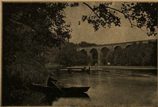
Viadukt bei Görlitz.
