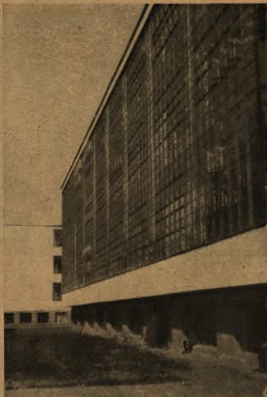
Bauhaus. Szklana ściana warsztatów.
