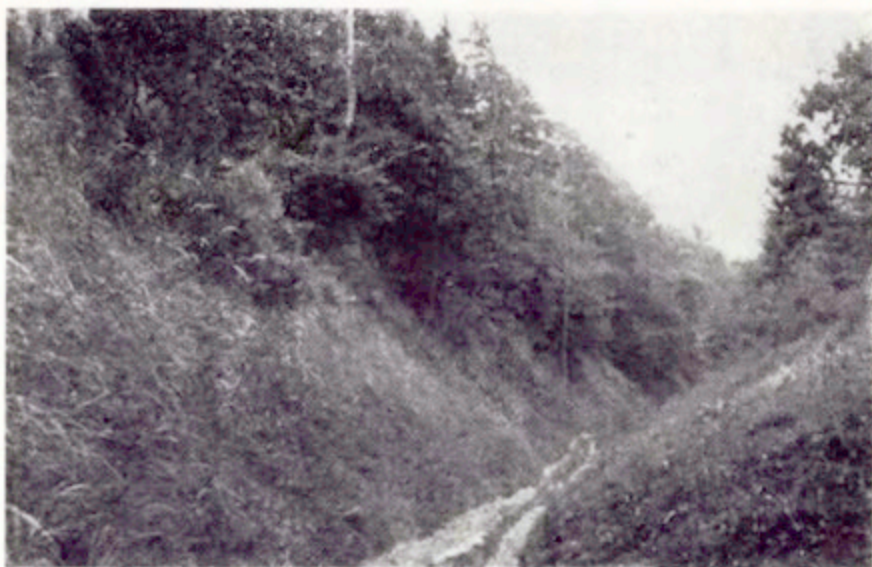
Fot. 8. Stare „utrwalone” przez roślinność wcięcie drogowe w lessach Pogórza koło Ropczyc — głębokość około 10 m.
