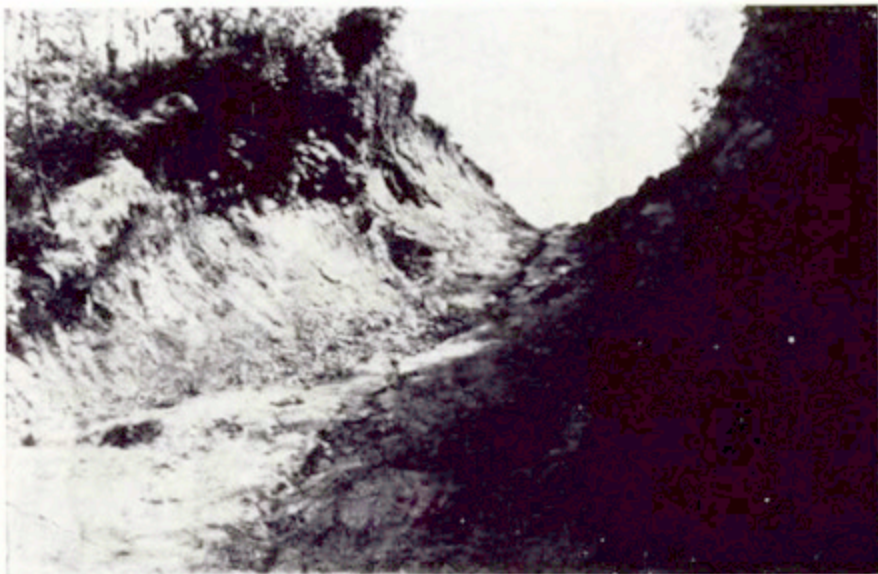
Fot. 7. Współcześnie rozwijające się wcięcie drogowe (holweg) w zwietrzelinie fliaszowej na Pogórze Ciężkowickim.
