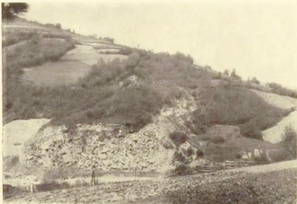
Fot. 1. Osuwisko w Lipowicy — widok ogólny Photo 1. Landslide at Lipowica — general view
