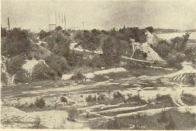
Fot. 1. Nieczynna część kamieniołomu cementowni „Odra”. Photo 1. Inactive portion of quarry of the “Odra” Cement Works.
