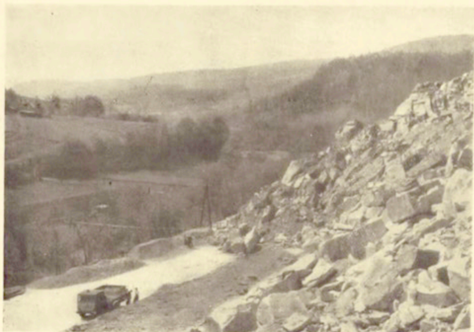
Fot. 2. Zwalisko głazów u czoła języka osuwiskowego Photo 2. Pile of boulders at the end of the landslide fan
