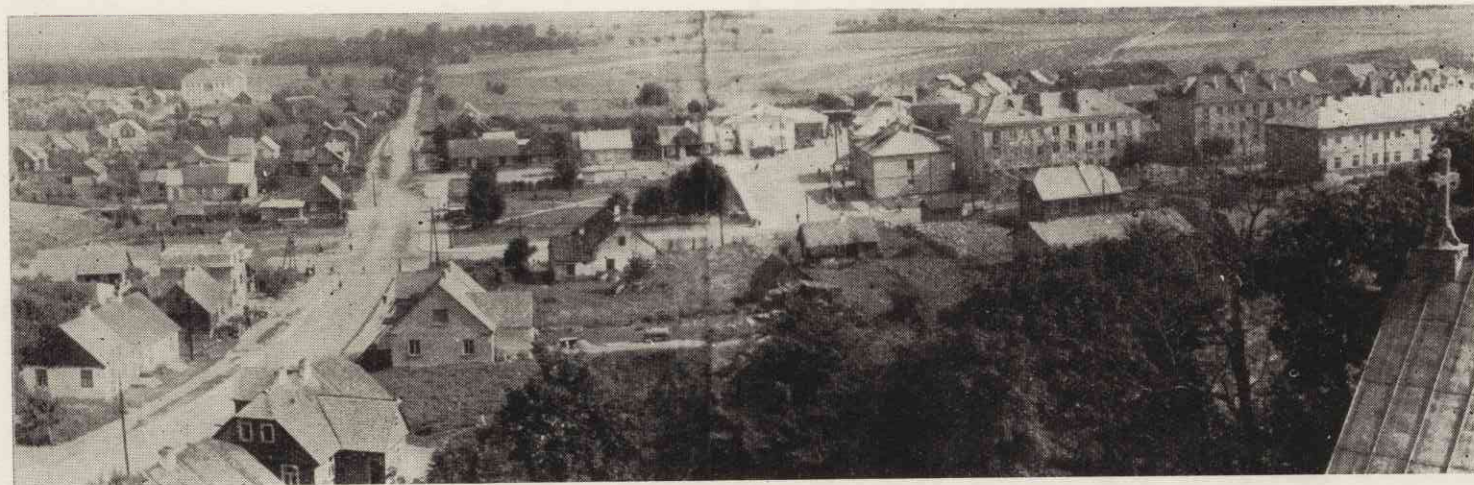
Fot. 8. Dąbrowa. Widok ogólny na centralną część osiedla, w której powstaje nowe osiedle mieszkalne.
