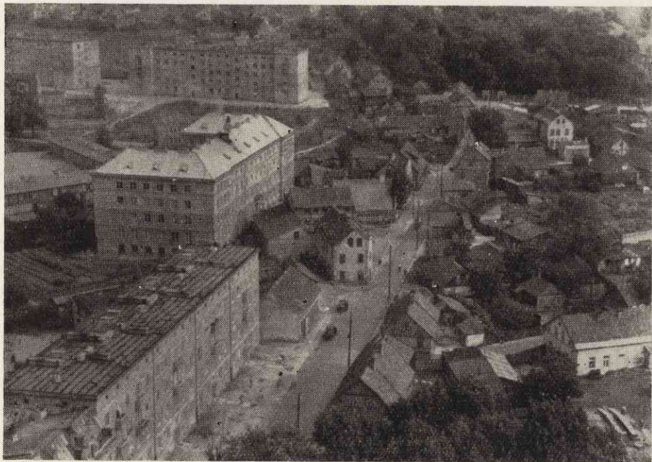
Fot. 4. Białystok. Nowe budownictwo powoduje przekształcenia w planie dawnych zaułków.
