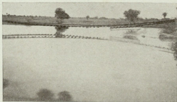
4. In der Luft hängendes Geleise einer weggeschwemmten Eisenbahnbrücke im Punjab, Herbst 1924 (f. S. 42).
