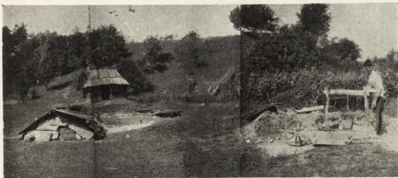
Ryc. 21. Wydobywanie glinki do bielienia za pomocą wiadra i kołowrotu. Na dnie szybu znajduje się robotnik, który kopie glinę. Tekucza, przys. Bania Świrska.
