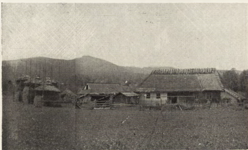
Ryc. 7. Cała zagroda z Osław Czarnych. Chata w połowie bielona, z malowanym zielonkawo-niebieskawym pasem u dołu. Druga połowa chaty nieukończona i na razie niebielona. W części bielonej i niebielonej mieszczą się we wnętrzu izby.
