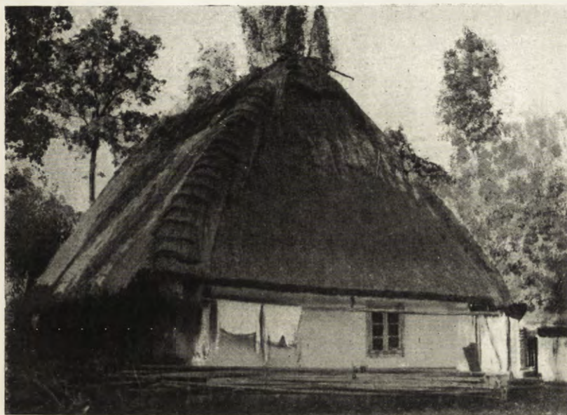
Ryc. 4. Chata ze Starych Kut, mająca około 80 lat. Chata drewniana, maszczona gliną i bielona. Z przodu (niewidoczne na ryc.) wyłożona do dolnej wysokości okien matą ze słomy („sołomienka“).
