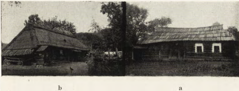
Ryc. 5. a jedna ze starych chat z Bani Berezów. Dach na chacie konstrukcji nowszej. Okna od izby naokoło wymaszczone pobieloną gliną. b chata z Czarnego Potoku. Daszek przed drzwiami wejściowymi do sieni zowią „ganoczok“, „stricha“, „striszka“ lub „piddasze“. Obie chaty drewniane.
