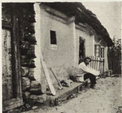
Ryc. 9. Chata stara, podobno blisko dwustoletnia. Chata kilkakrotnie przerabiana, maszczona gliną i bielona. Pistryń.
