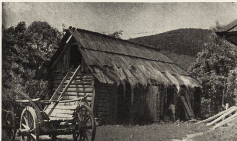
Ryc. 11. Stajnia, Szeszory. Przód stajni i narożniki przednie budowane na słup, tylne na węgiel.
