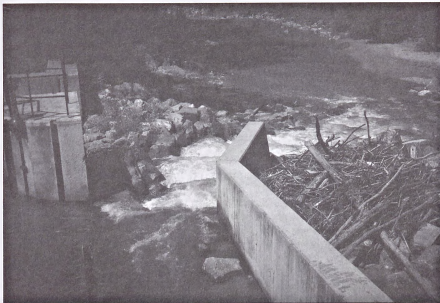
Ryc. 3. Przeławka dla ryb w formie bystrotoku – rampa ryglowa (fot. W. Wiśniewski).
