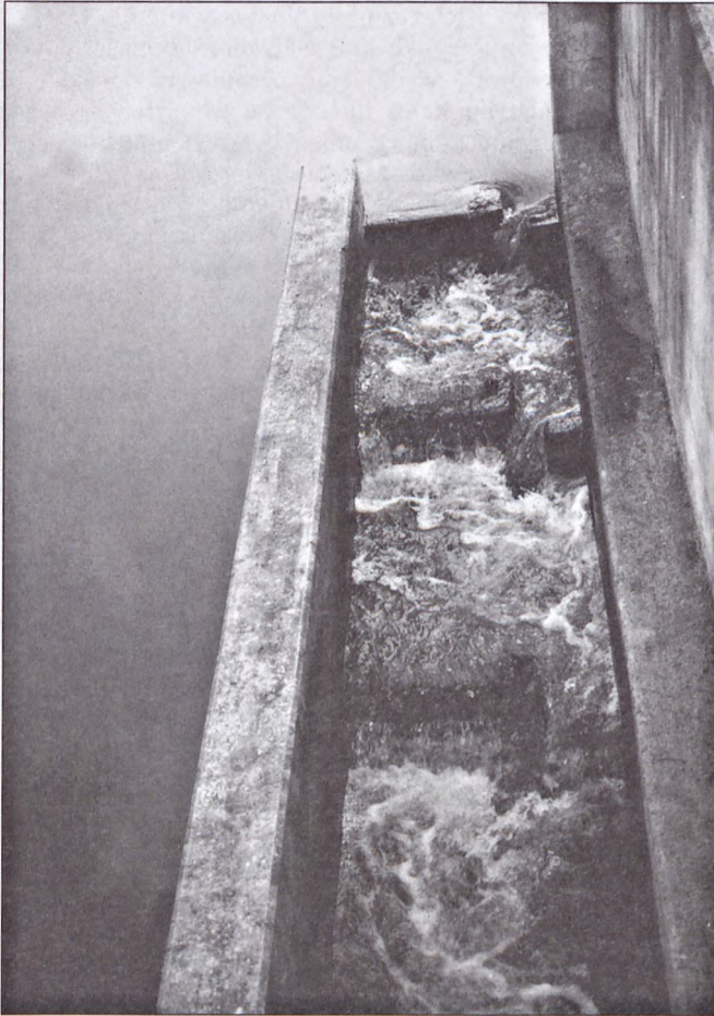
Ryc. 5. Przeławka szczelinowa (fot. PZW).
