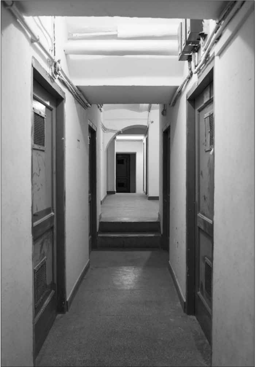
22. Piwnice Pałacu Staszica
