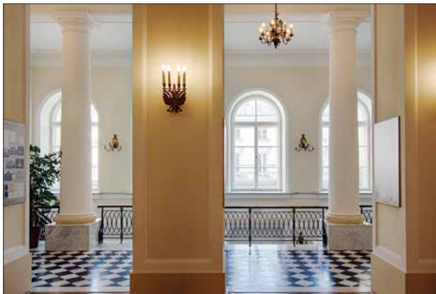
55. Widok ściany południowej na wysokości I piętra od wewnątrz
