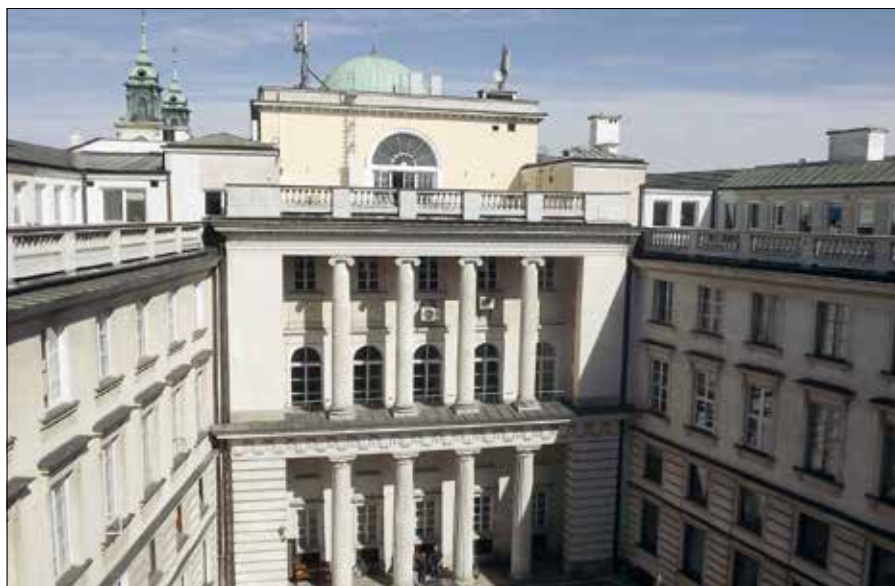
52. Dziedziniec wewnętrzny Pałacu Staszica, widok z tarasu od strony ul. Świętokrzyskiej
