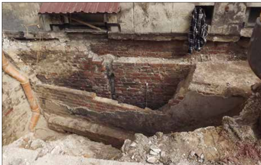
44. Widok fundamentów odsłoniętych podczas remontu, dziedziniec Pałacu Staszica
