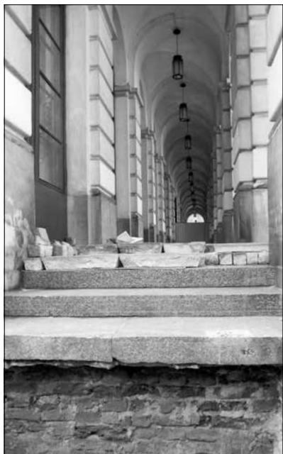
12. Arkady Pałacu Staszica, widok fundamentów w czasie remontu w 2016 roku
