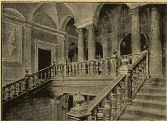
Dom zdrojowy: klatka schodowa.
