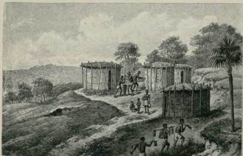
Das im Bau begriffene Matokadorf Jankuba.
