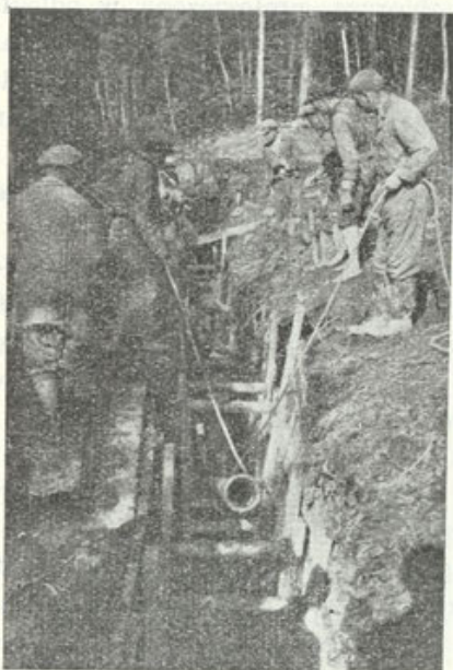
Ryc. 2. — Układanie rurociągu.
