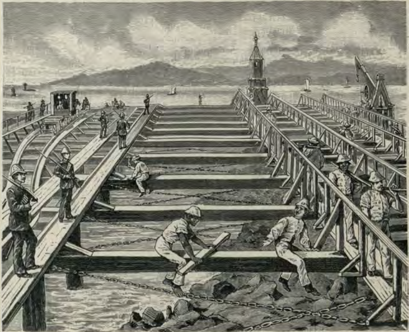
Hafenbauten in Capstadt.
