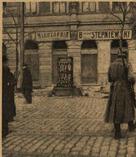
Wysadzony transformator przy ulicy Chłodnej.
