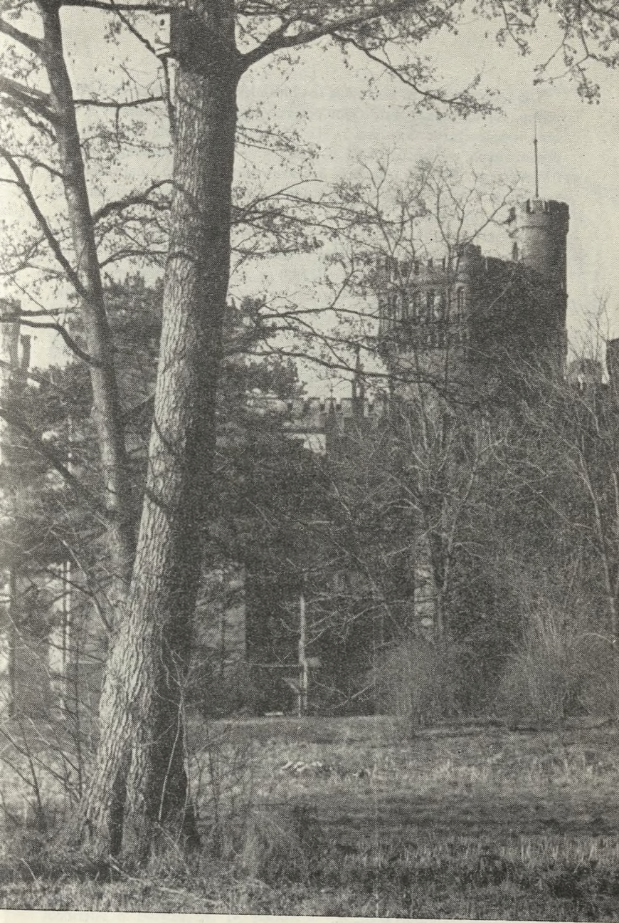
1. Widok zamku z alei jesionowej przy sekcji 5 i 7
