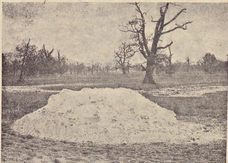
Ryc. 4. Ujście kanału ściekowego na łąki zalewowe koło Rogalinka. — The outlet through which sewage is discharged on the meadows of Rogalinek. Fot. Z. Pniewski
