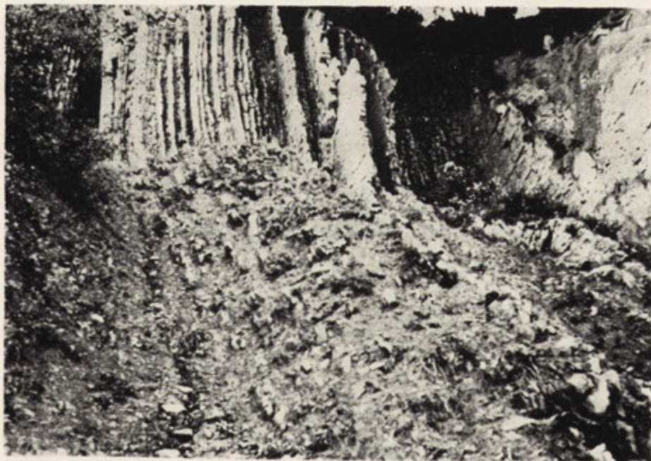
Fot. 16. Cofająca się ściana łupków na podcięciu Sanu w Woli Postołowskiej
