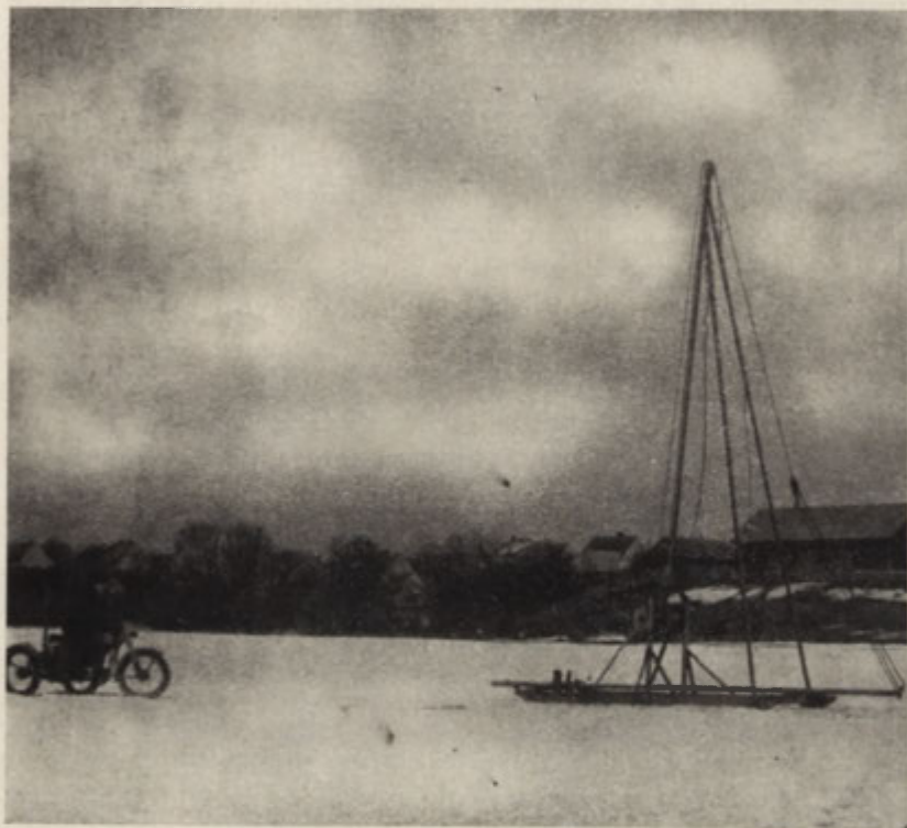
Fot. 2. Zestaw do wydobywania osadów dennych (sonda rdzeniowa, winda z masztem wyciągu i urządzenia pomocnicze), zmontowany na specjalnych saniach
