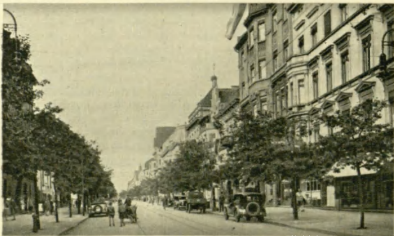
Bydgoszcz, ul. Kolejowa.
